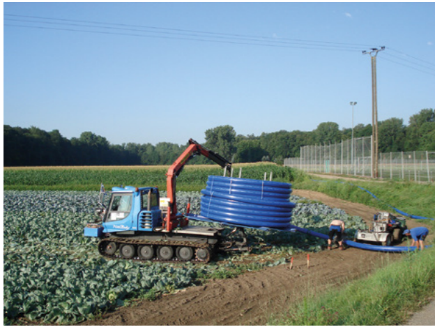
Verlegung der Leitung vom neuen Brunnen zum Brunnen Erlenschachen. Errichtung der Brunnenfundamente.
