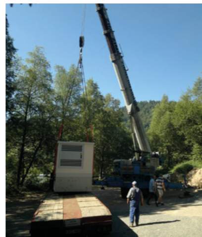
36_20kV-Trasse ersetzt Freileitung
