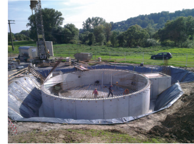
Fertigstellung der Wände des Durchlaufbeckens. Rechts: Planskizze des Projekts. Darunter: Verfüllung.
