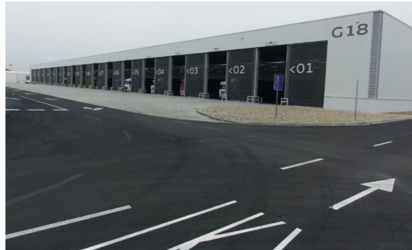
Die von BIT Ingenieure und gevas humberg & partner ermittelte Vorzugsvariante für den südlichen Wareneingang wurde umgesetzt
