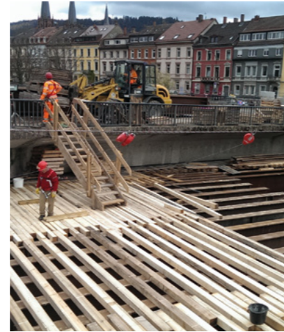
28 Arbeiten gut abgesichert
