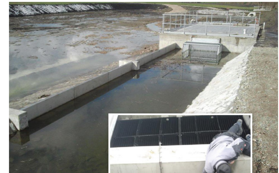
In Bad Dürkheim haben die BIT Ingenieure einen Lamellenklärer realisiert
